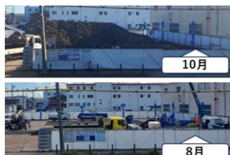
<2023年夏> 基礎工事
